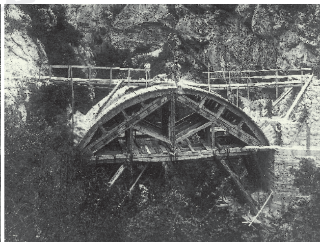
Lavori di ricostruzione del ponte sul Ponale, sulla strada per Pregasina (Museo Storico Italiano della Guerra).
